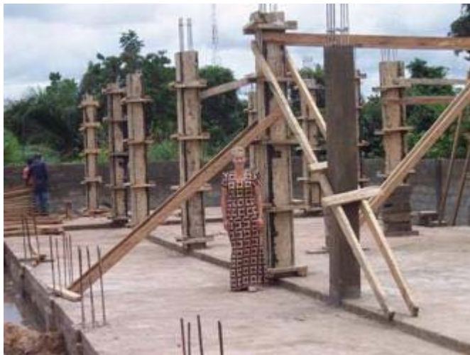
Fundament für das Schlafgebäude mit den Pfeilern für die zweite Etage
