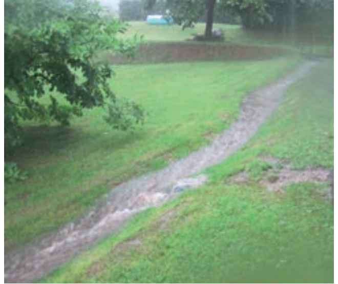
129 Entwässerungsmulde im Wohngebiet
