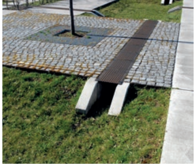
22 Detail eines Muldenzulaufes
