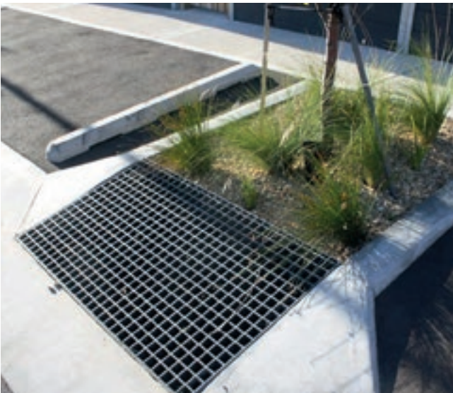
31 Einleitung wenig belasteter Straßenabflüsse in Pflanzgrube
