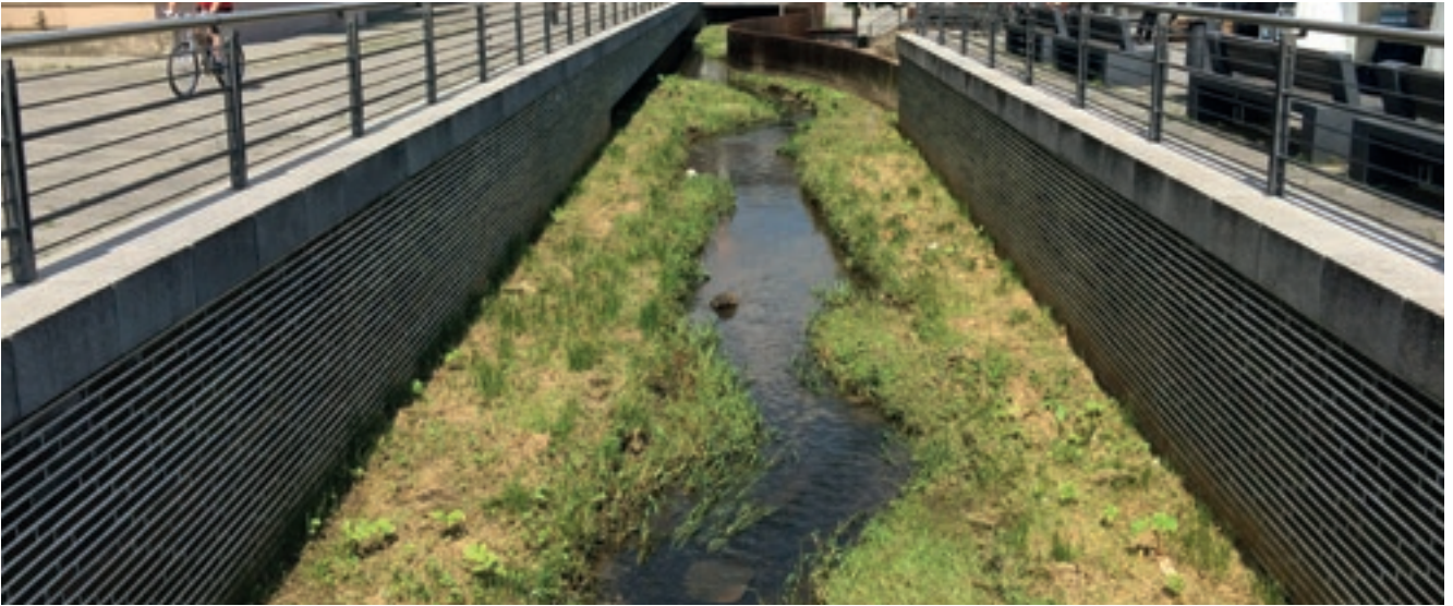
57 Reaktivierung eines Baches zur Schaffung von Retentionsraum und attraktiver Uferbereiche
