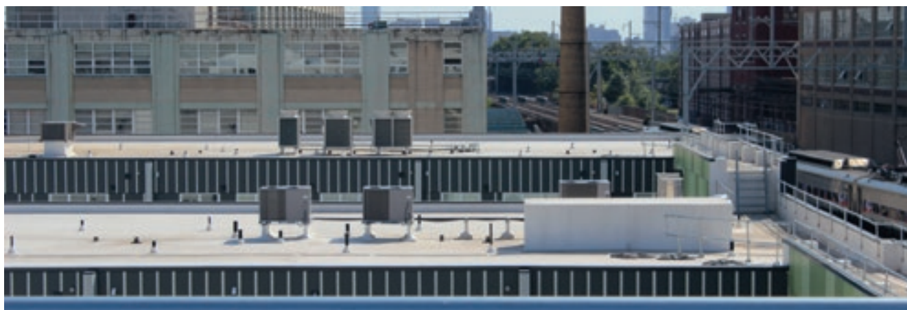
46 Dach mit erhöhter Regenauffang- und Rückhaltekapazität
