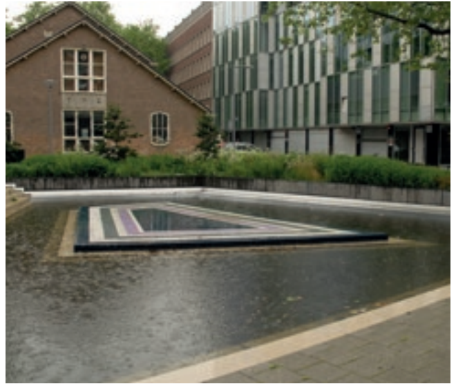
101 Füllung des Platzes während eines Starkregens
