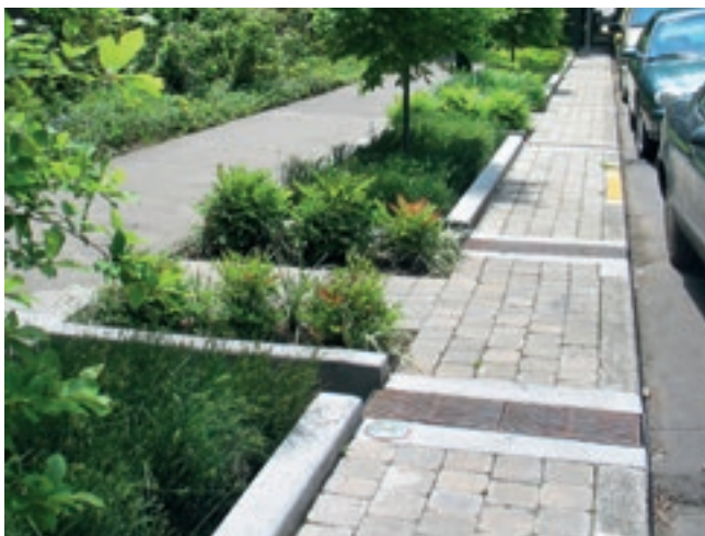
28 Versickerung über Tiefbeete im Straßenseitenraum
