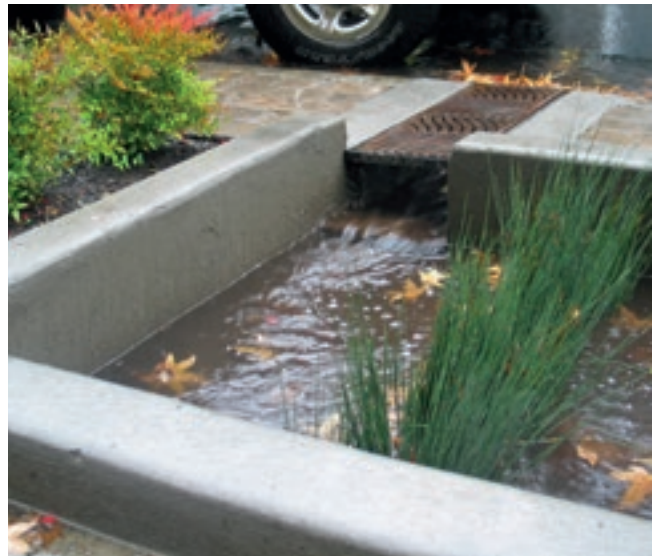
32 Zuleitung wenig belasteter Straßenabflüsse in ein Tiefbeet
