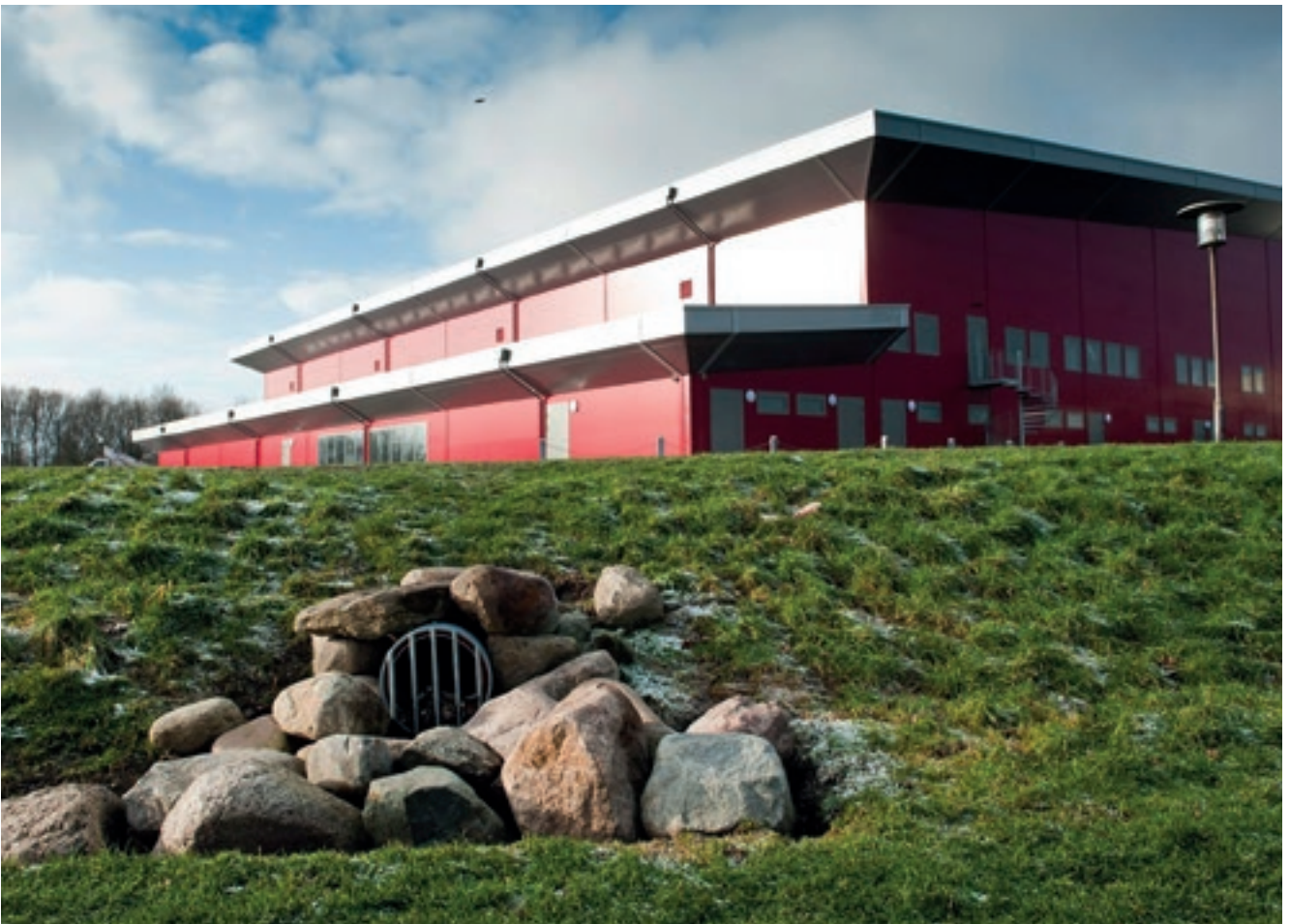
109 Auslass in Versickerungsmulde
