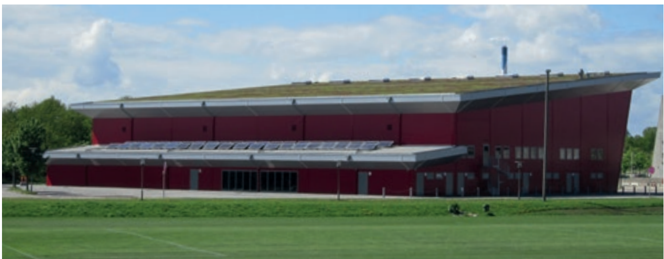
106 Notüberlauf in Sportanlage
