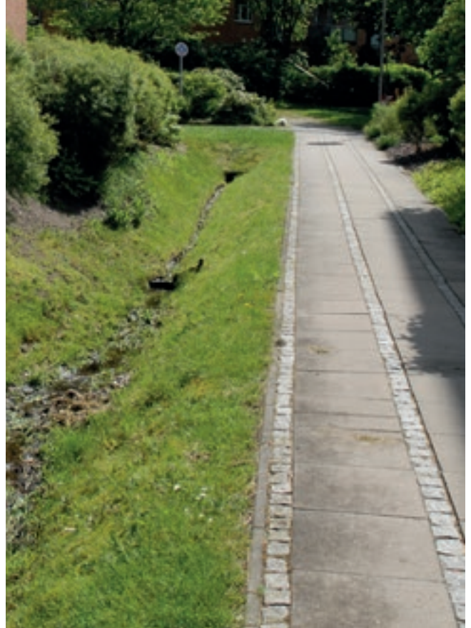
36 Ableitung über Entwässerungsgraben
