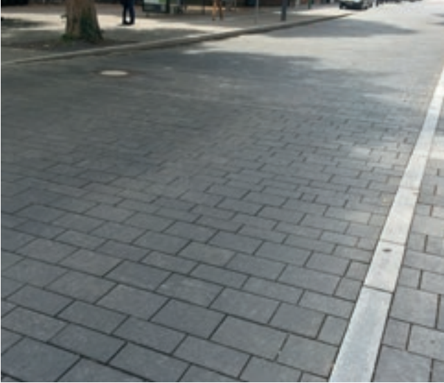
53 Abgesenkte Straße zum temporären Rückhalt von Abflussspitzen
