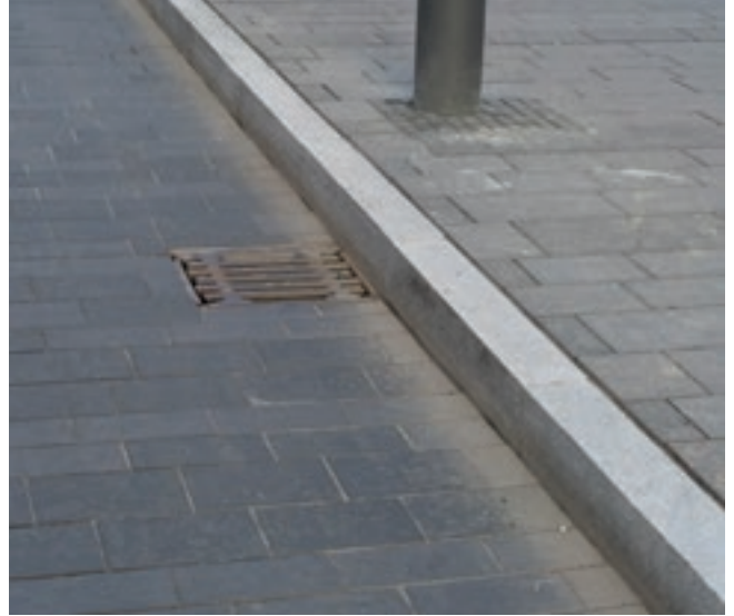
54 Erhöhte Bordsteine zur Verbesserung des Regenwasserabflusses
