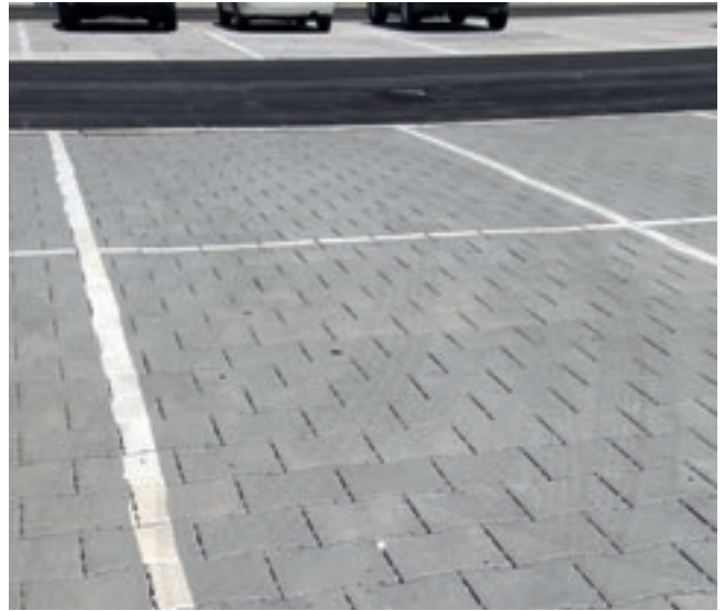
26 Versickerungsfähiges Pflaster
