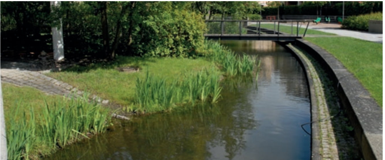
23 Offene Wasserfläche als Retentionsraum für Regenabflüsse
