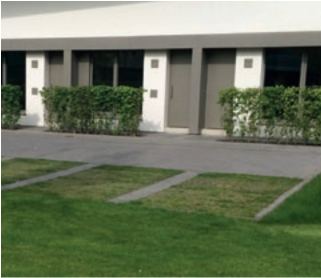
25 Wasserdurchlässiges Rasengitter auf Stellplatzfläche
