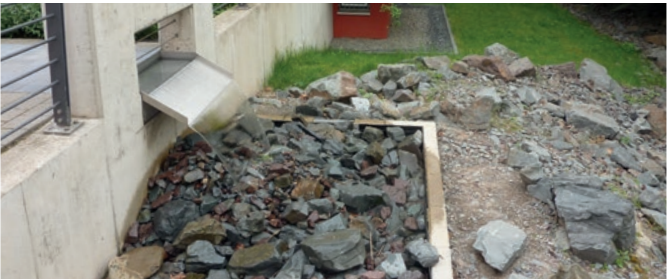
33 Ableitung von Gehwegabflüssen in eine Versickerungsanlage
