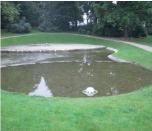
130 Zustand nach einem Starkregenereignis
