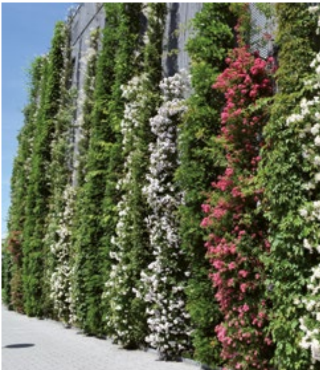
25 Beispiel für eine bodengebundene Fassadenbegrünung
