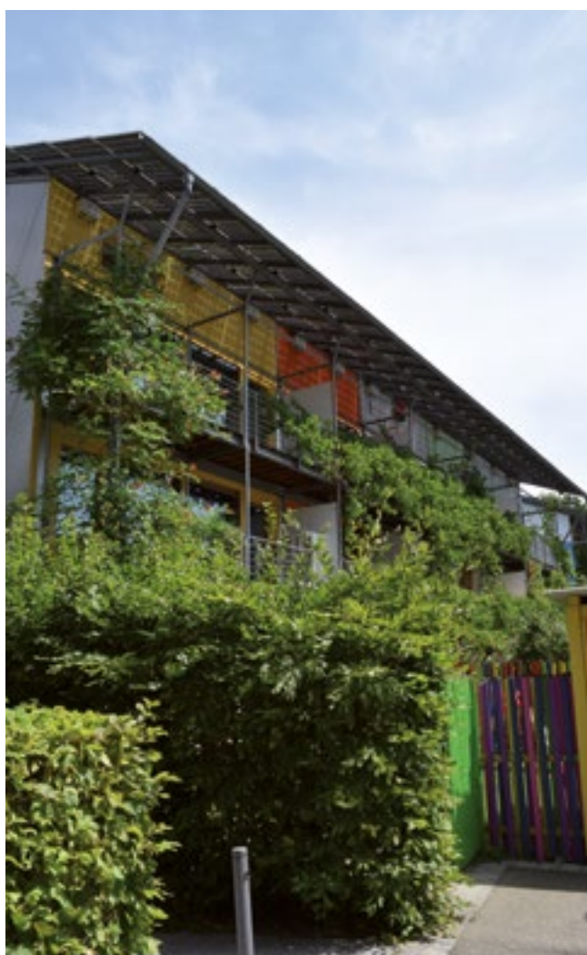
30 Beispiel einer Fassadenbegrünung an einem Wohngebäude
