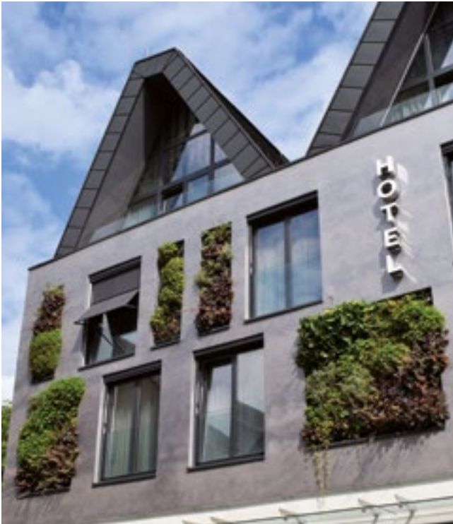
26 Beispiel für eine wandgebundene Fassadenbegrünung
